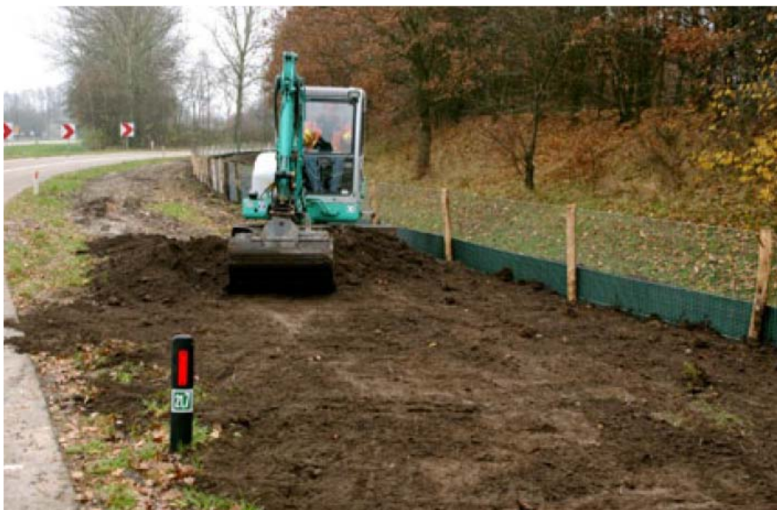
Figuur 7.3 Voorbeeld van een amfibieënraaster (Prudon & Creemers, 2004; Wansink et al., 2013)
