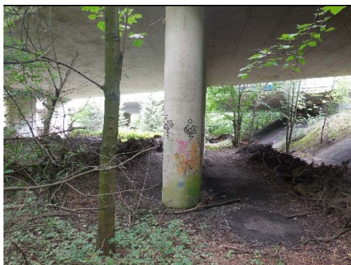
Figuur 3.7 Faunapassage ten zuiden van de Weg over Anna's Hoeve
