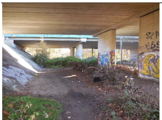
Figuur 3.5 Faunapassage ten noorden van het spoor
