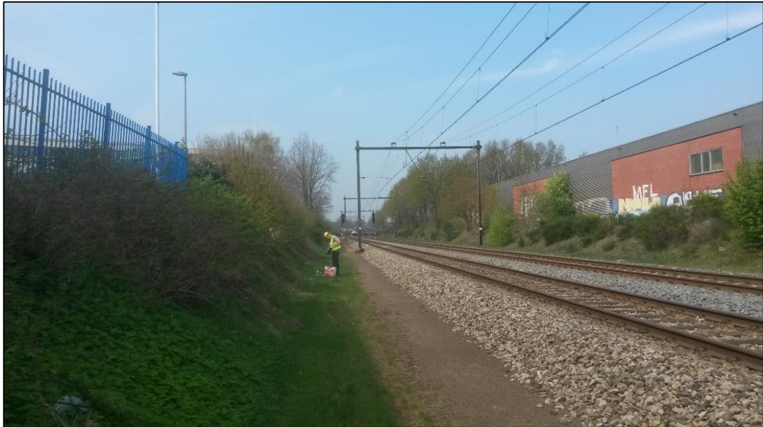
Figuur 4 Impressie van deellocatie 2, met links en rechts van de spoorlijn duidelijk het talud van de stuwwal.
