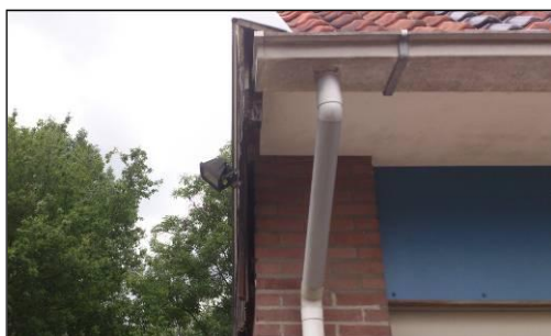
Foto 4: Gevelbetimmering en pannendak
