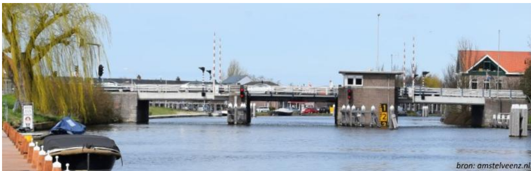
Afb. 1.2 De brug vanuit het zuiden gezien
