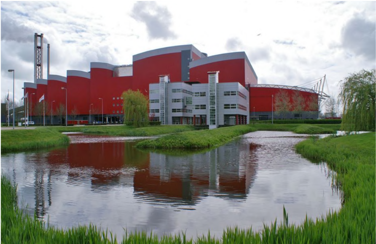
Afbeelding aanzicht HVC energiecentrale
