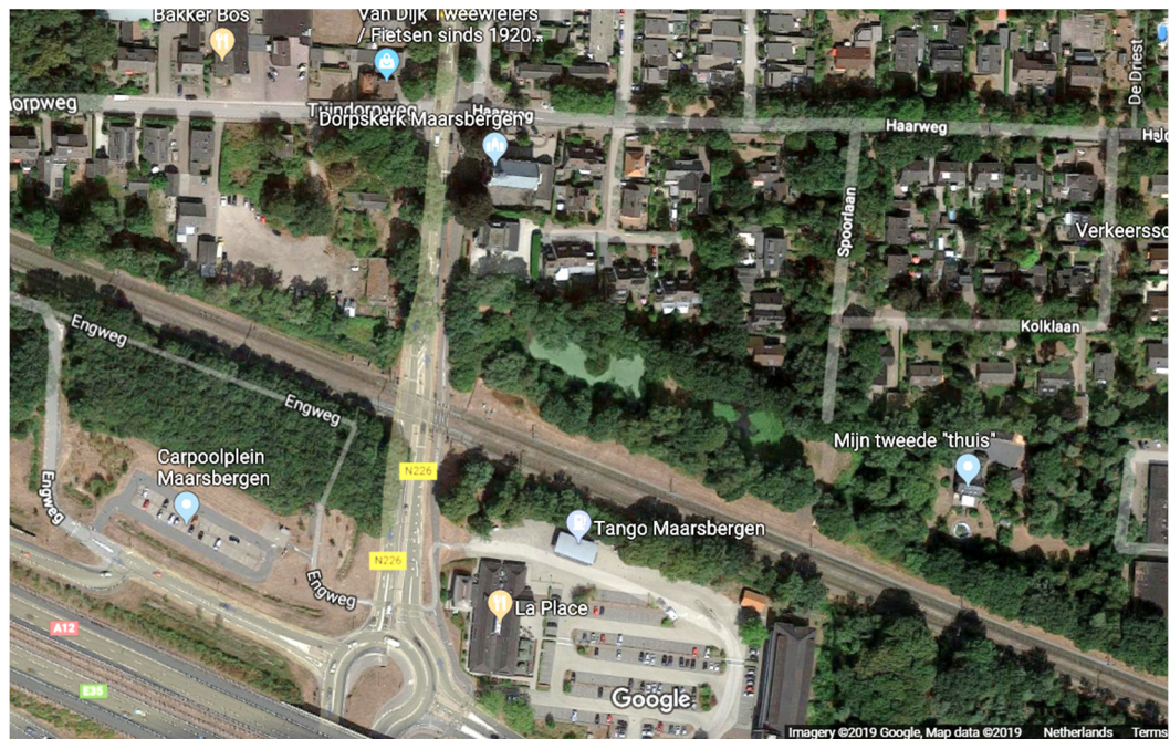
Figuur 2 Huidige situatie van het knooppunt N226 bij Maarsbergen met zicht op de spoorlijn
