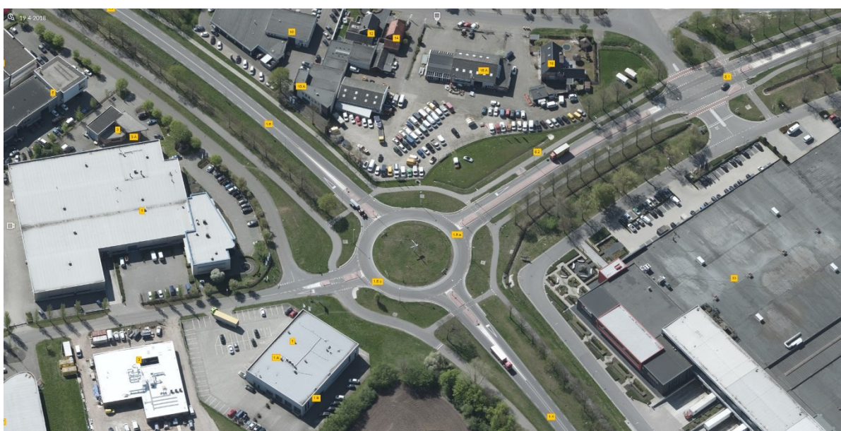
Figuur 7 Luchtfoto rotonde km. 1.5
