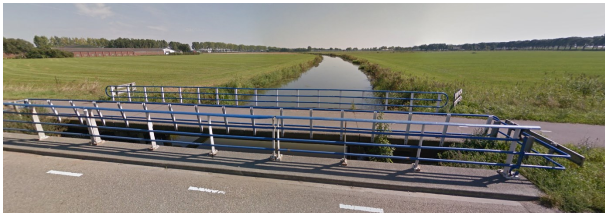
Afbeelding 9: Aparte brugdelen over de Hoofdwetering
