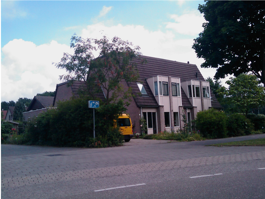
Mondriaanlaan 2 en 4, twee onder een kapwoningen
