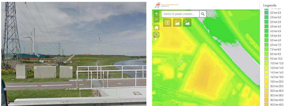
Figuur 2-4 Geplande locatie WT3 (links) aan de zuidzijde van het Twentekanaal (bron: Google Earth) en hoogtegegevens stort (AHN-viewer)
