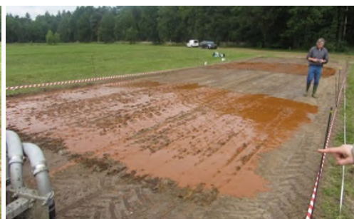
D. INJECTEREN IJZERSLIB NA ZODE VERWIJDERING
