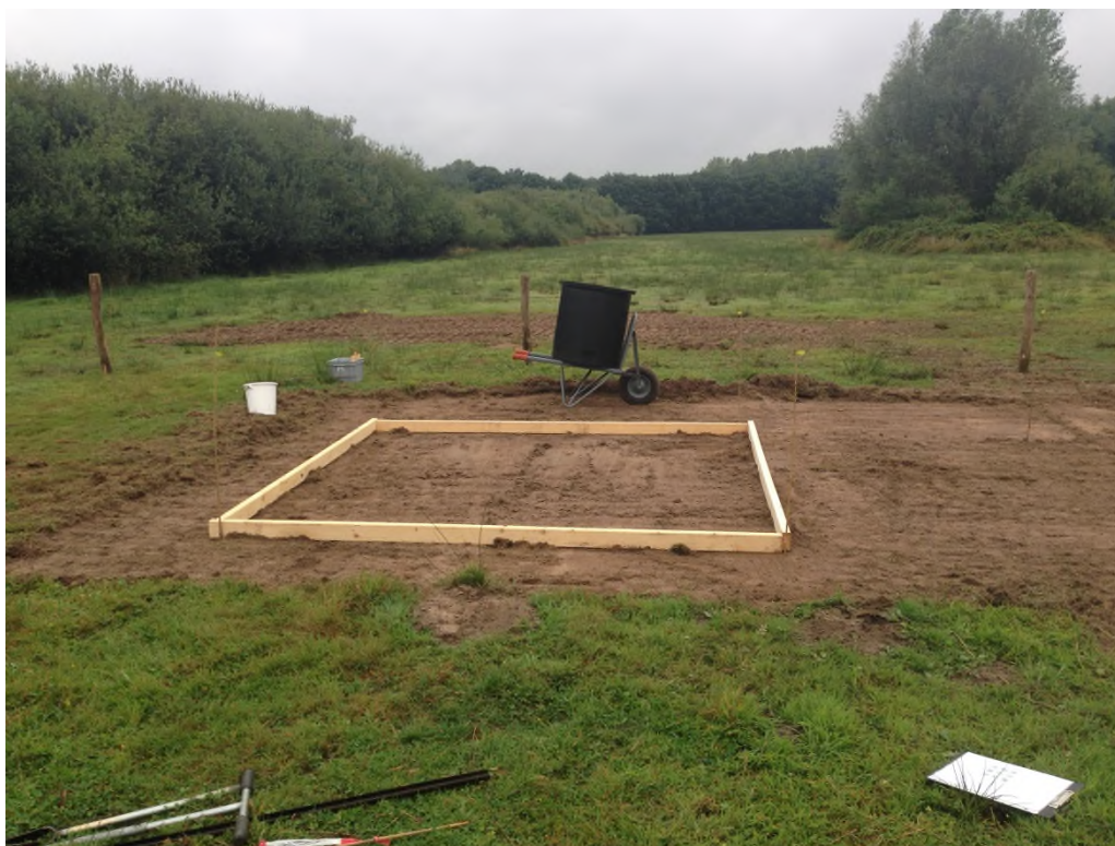
FIGUUR 3-5. VOORBEELD VAN DE BEKISTING, HIER IN DE SCHEEKEN.
