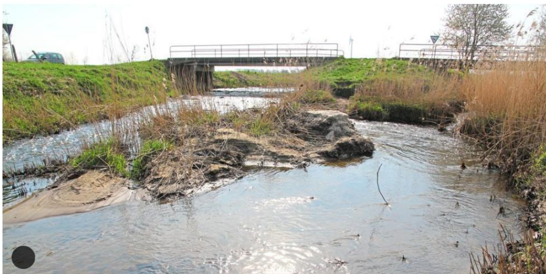
Kurz hinter zwei Brücken fließt der Strothbach (r.) in die Dinkel. Auch wenn die Bäche teilweise durch Naturschutzgebiete fließen, ist ihr ökologischer Zustand sehr schlecht. Foto: Frank Zimmermann
