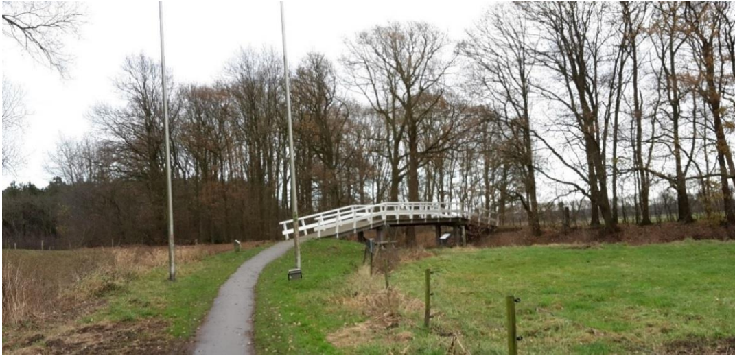
Figuur 5.3 Voorbeeld van een fietsbrug over de Dinkel
