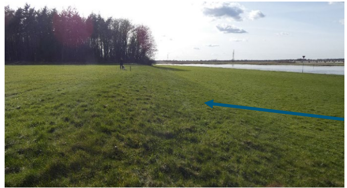
Figuur 5-8: Impressie steilrand bij Achterweerd Noord met zicht op bestaande Fortmonderbos
