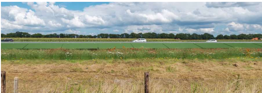
Afbeelding 4.23 Onderzijde van de panelen worden afgeschermd met natuurlijke materialen
