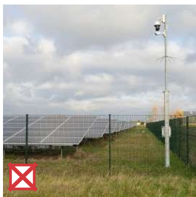
Afbeelding 4.10 Hekwerk rond zonnepanelen moet vermeden worden, een betere keuze is het aanbrengen van een watergang ter beveiliging tegen onbevoegden
