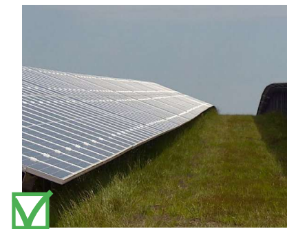
Afbeelding 4.16 Ruimte tussen panelen dient groen en onverhard te zijn
