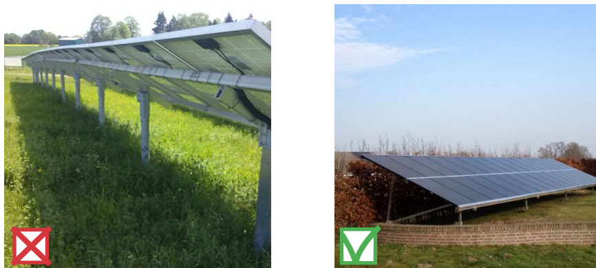
Afbeelding 4.12 De panelen worden zo laag mogelijk gelegd zodat het zicht op het landschap behouden blijft
