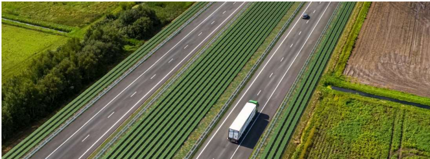
Afbeelding 4.21 lange lijnen van laag liggende panelen zorgen voor rust, continuïteit en uniformiteit
