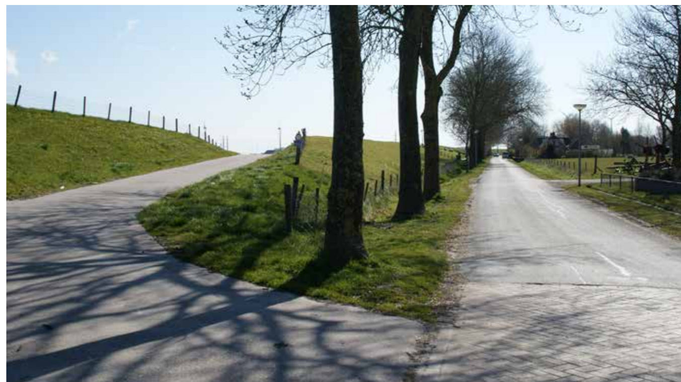
Karakteristieke afwegen. Schuin gelegen wegen om de hoogte van de dijk te kunnen overbruggen. (Bron: BügelHajema)
