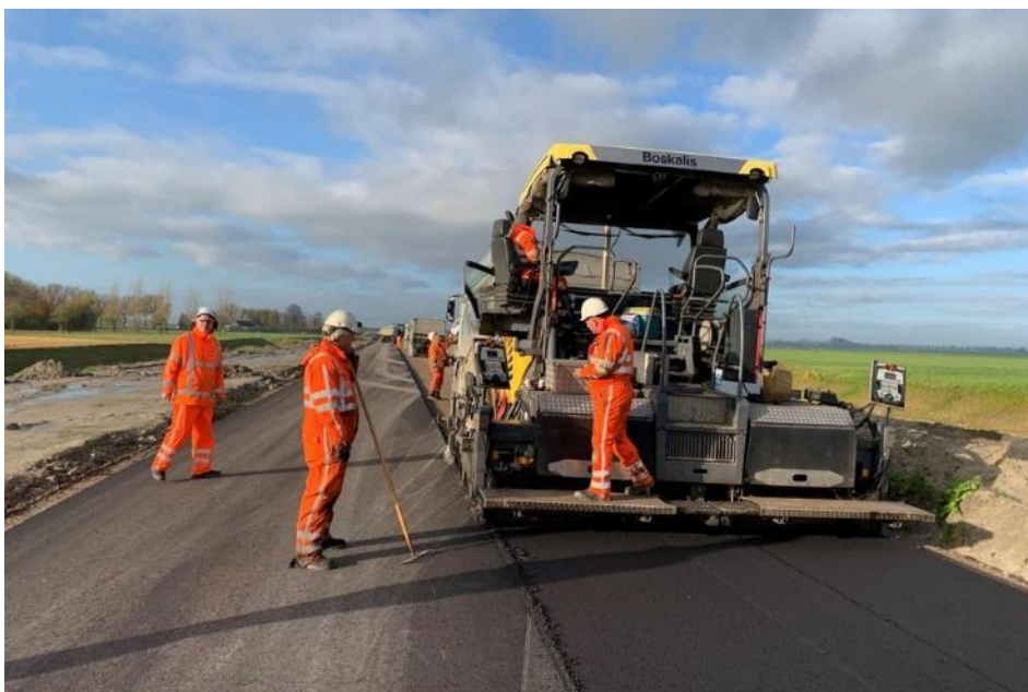
Figuur 1: aanbrengen asfalt met een spreider
