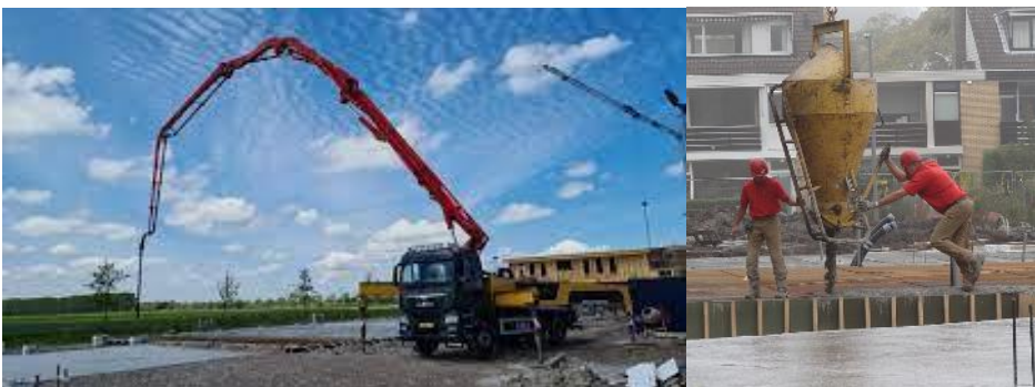
Figuur 2: betonpomp (links) en kubel (rechts)
