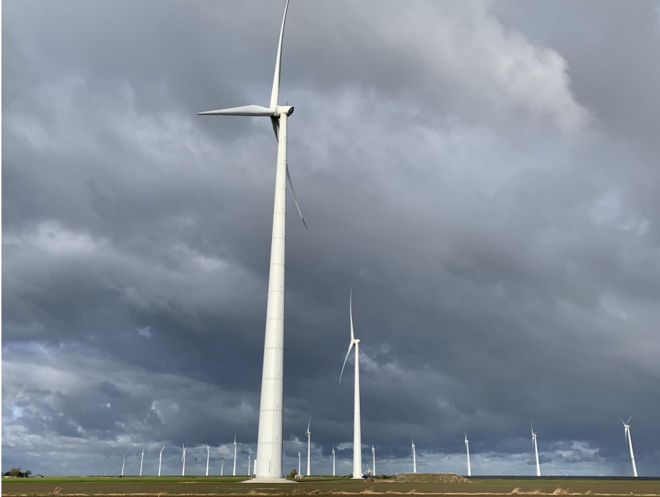
Figuur 2-8 Een van de depots, nabij de nieuw gebouwde windmolens, foto genomen vanaf de Klaas Wiersumsweg
