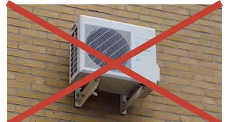
Buitenunit warmtepomp integreren in berging
