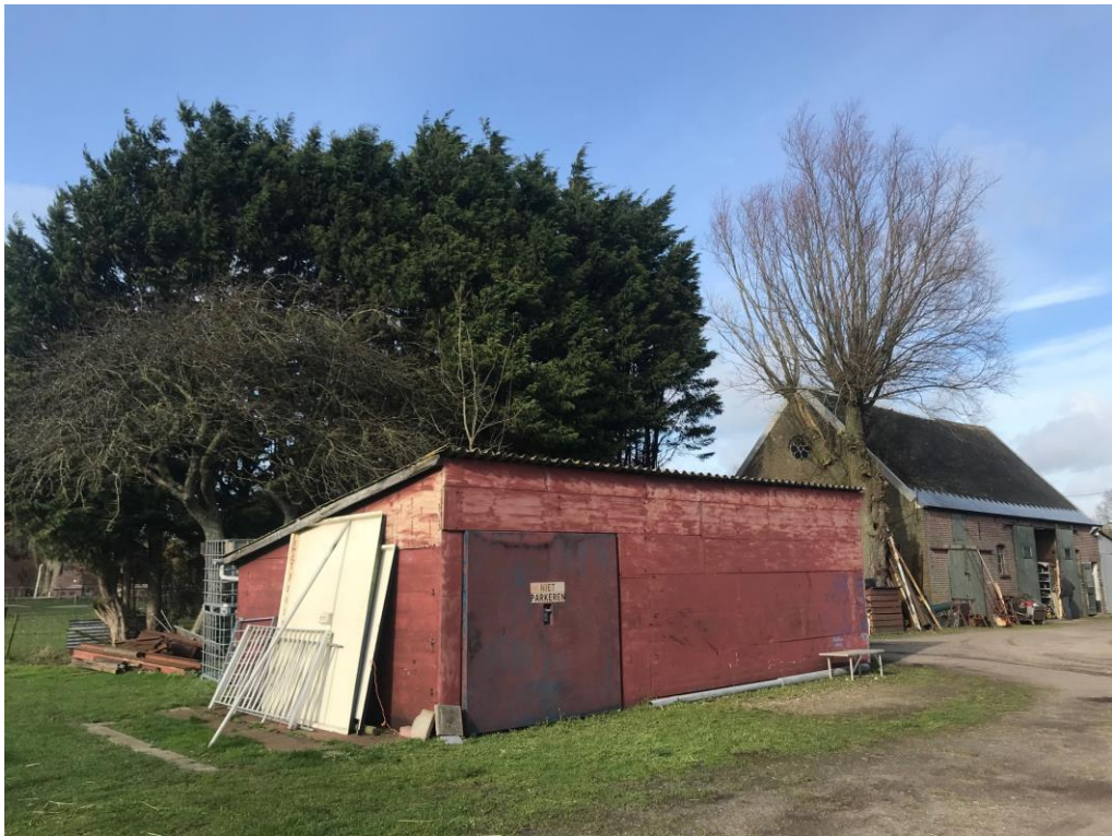
Figuur 5 Een houten opslagschuur op de planlocatie, deelgebied 2
