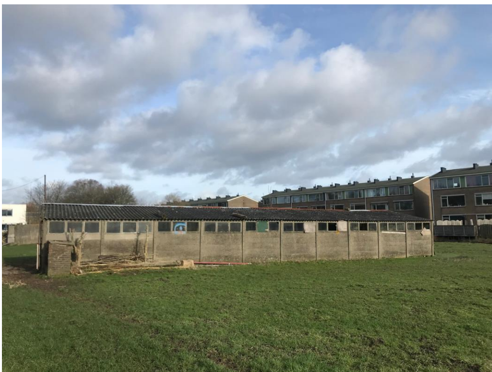
Figuur 7 Schapenstal op de planlocatie, deelgebied 2
