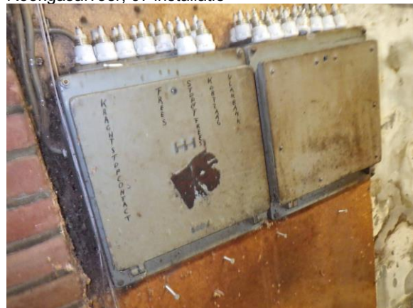
Asbestverdachte schakelkasten
