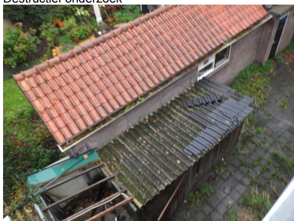
Asbesthoudende golfplaten, overkapping
