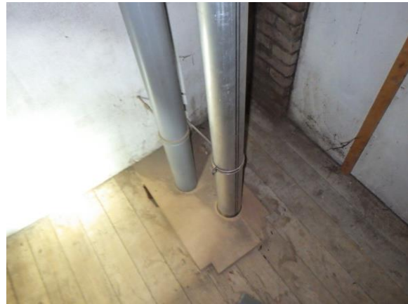
Rookgasafvoer, cv-installatie
