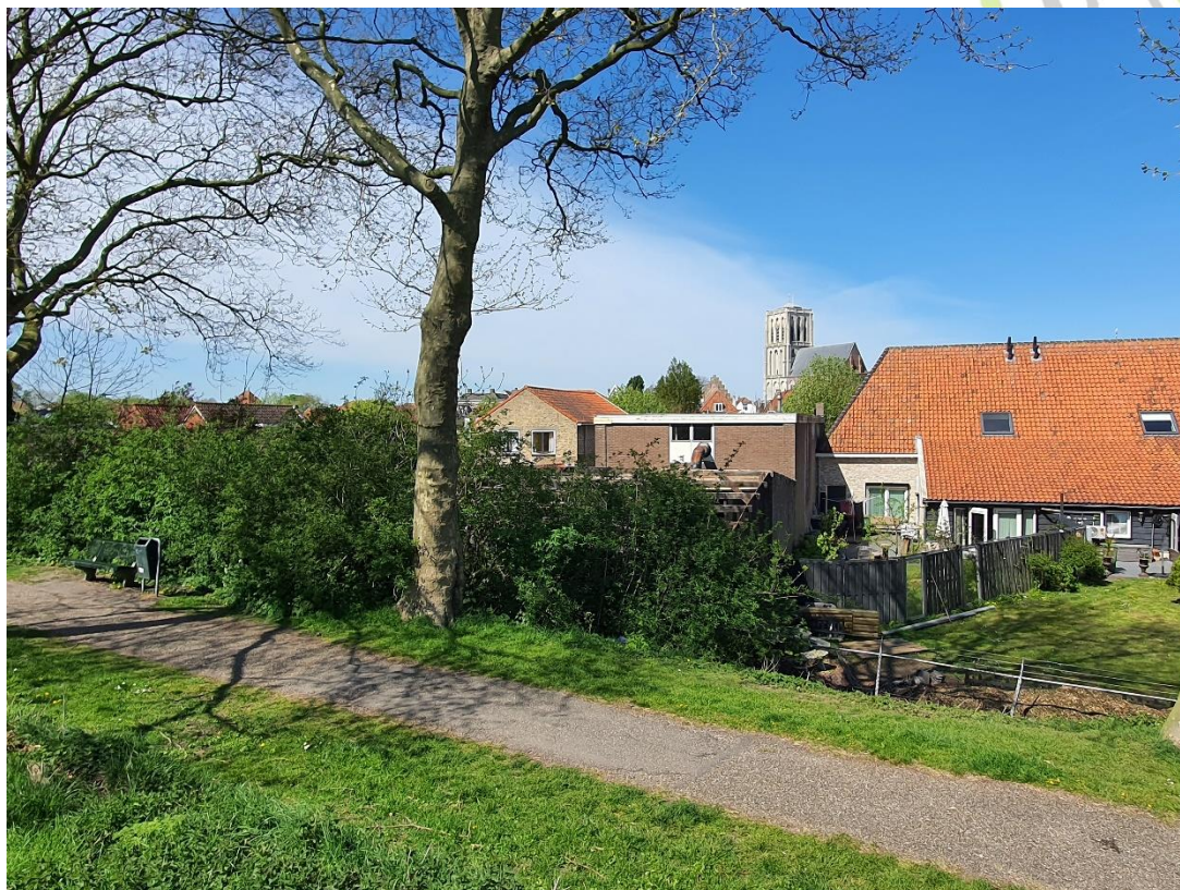
Plangebied Scharloo 19, Brielle, achterzijde pand
