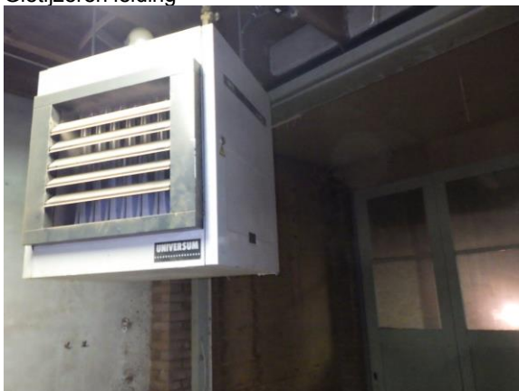
Asbestverdachte luchtverhitter
