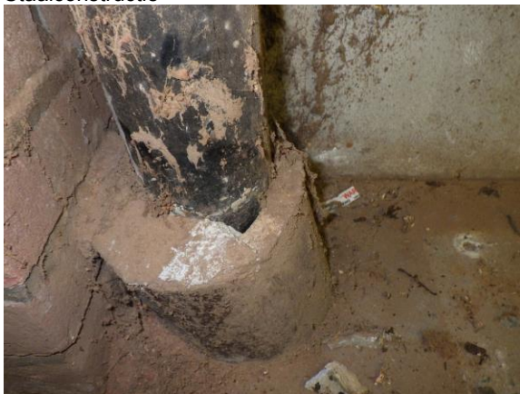
Gietijzeren leiding
