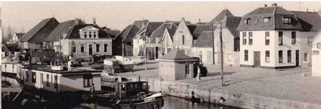
Figuur 2.1 gebouwtje bij weegbrug Turfkade
