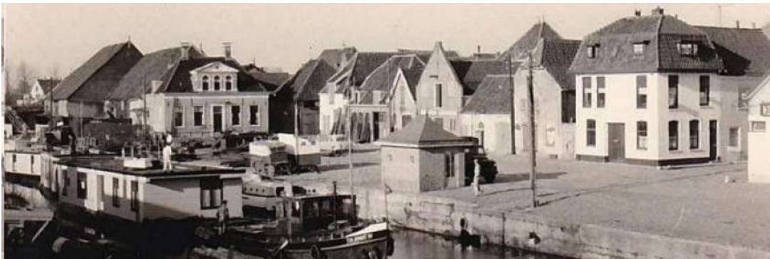
Figuur 2.1 gebouwtje bij weegbrug Turfkade
