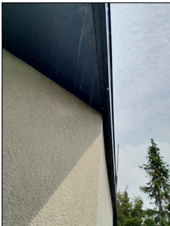
Afbeelding 10: De aansluiting van de boeidelen met het dak. Foto: M.S. de Haan / Ecoresult B.V.
