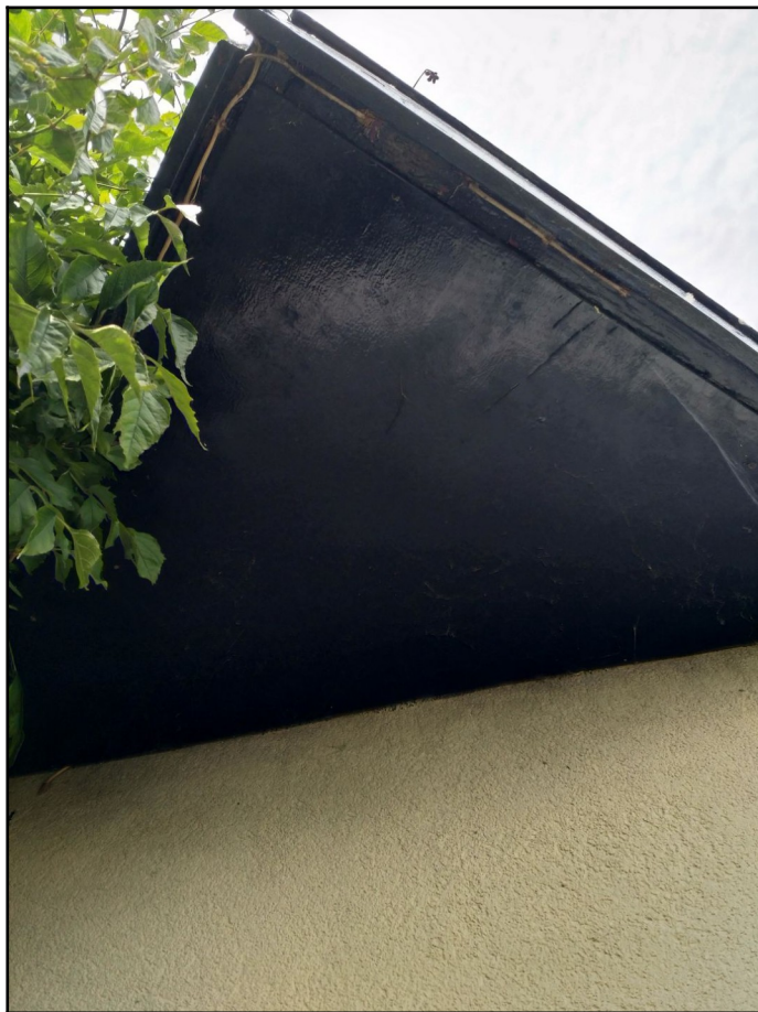
Afbeelding 8: Het platte dak en muuraangrenzing. Gezien van de grond. Foto: M.S. de Haan | Ecoresult B.V.
