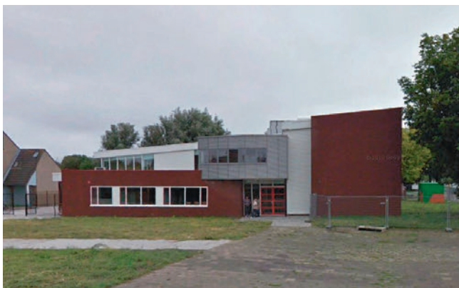
Nieuwe school 't Schrijverke
