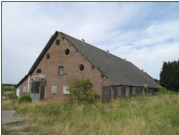
Figuur 3. De boerderij langs de Dijkweg gezien vanuit zuidelijke richting.
