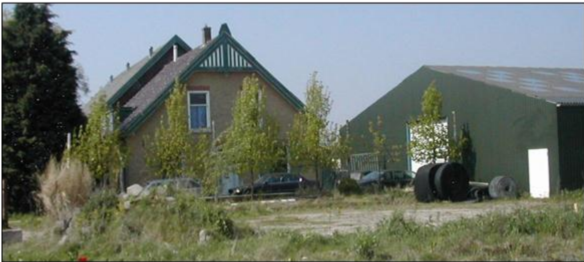
Figuur 4 Bestaande situatie voorhuis met aangebouwde schuur en stalen bijgebouw.
