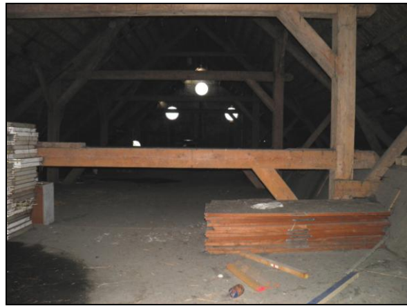
Figuur 8. Overzicht van de zolder in de boerderij gezien vanuit oostelijke richting.
