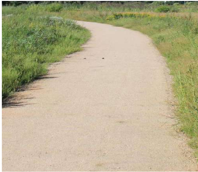
Referentiebeeld voor halfverharde wegen met bijvoorbeeld Graustabiel of Nobrecal op een puincunet.
