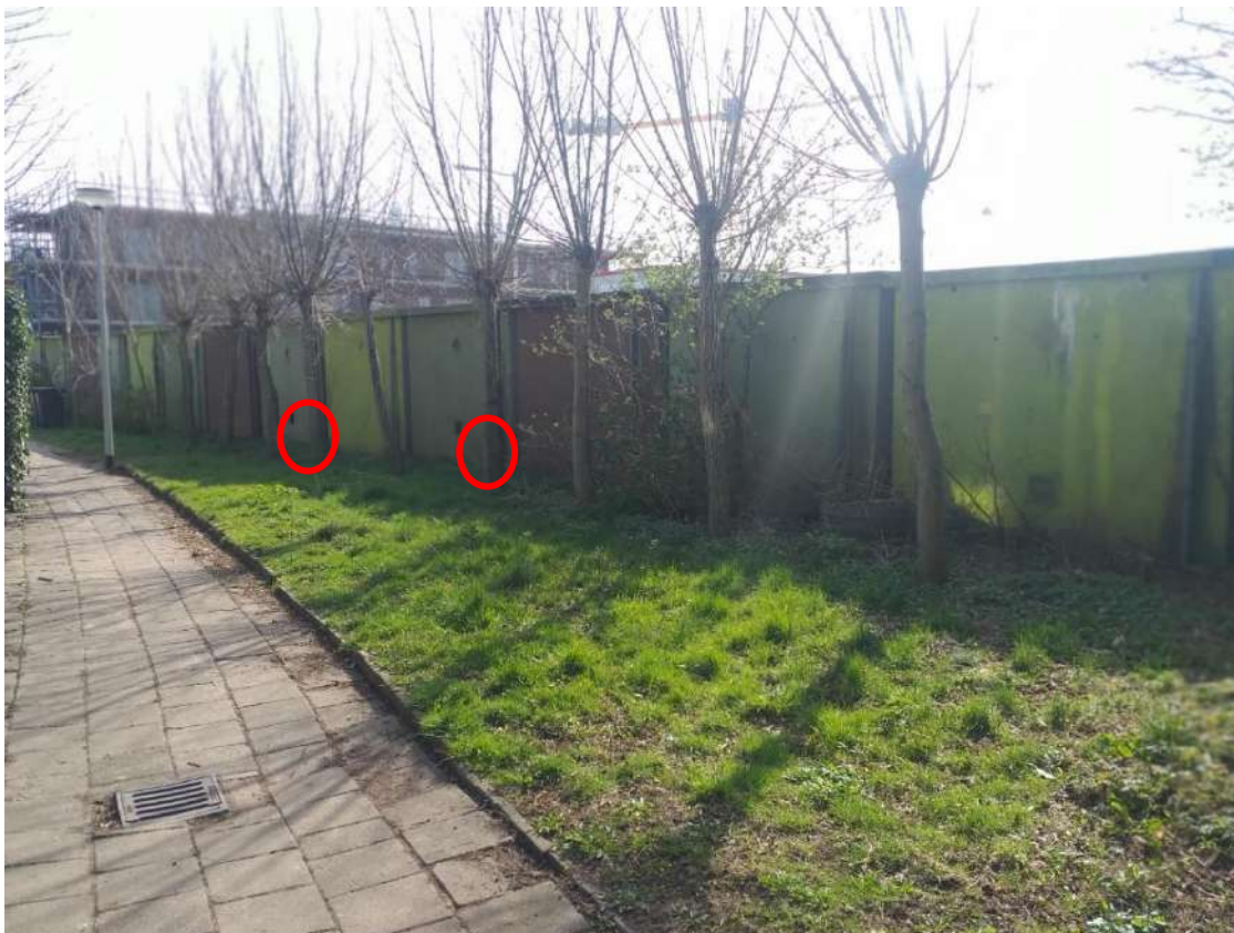
Figuur 5. Achterkant deel van de garageboxen met kapotte luchtroosters (rode cirkels).
