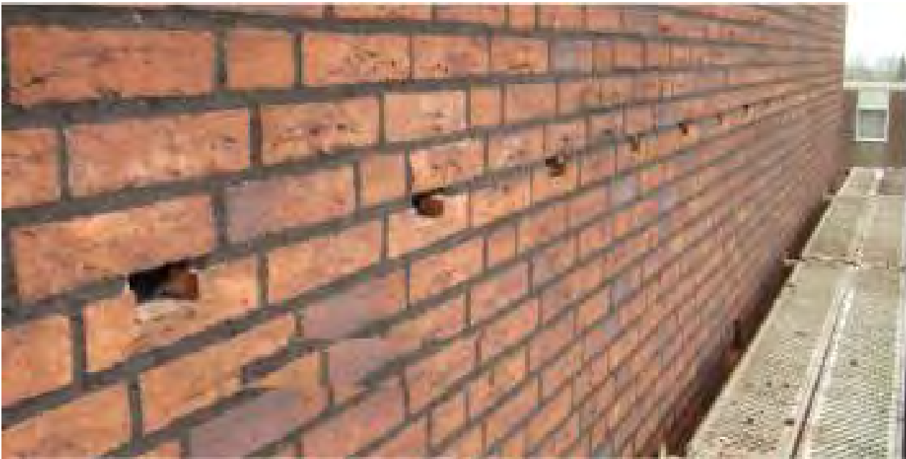
Figuur 8 en Figuur 9. Een weggewerkte nestvoorziening en zichtbare nestvoorzieningen voor huismus/ gierzwaluw.
