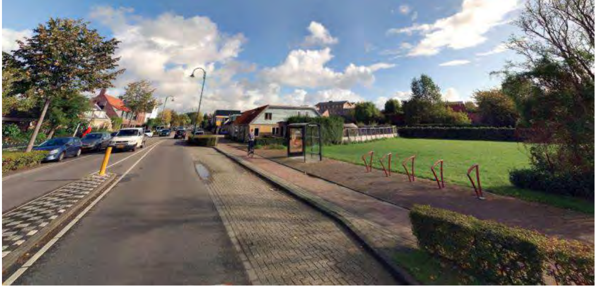
Figuur 3.8: Huidige bushalte aan de Rijksstraatweg, ter hoogte van de Parnassialaan
