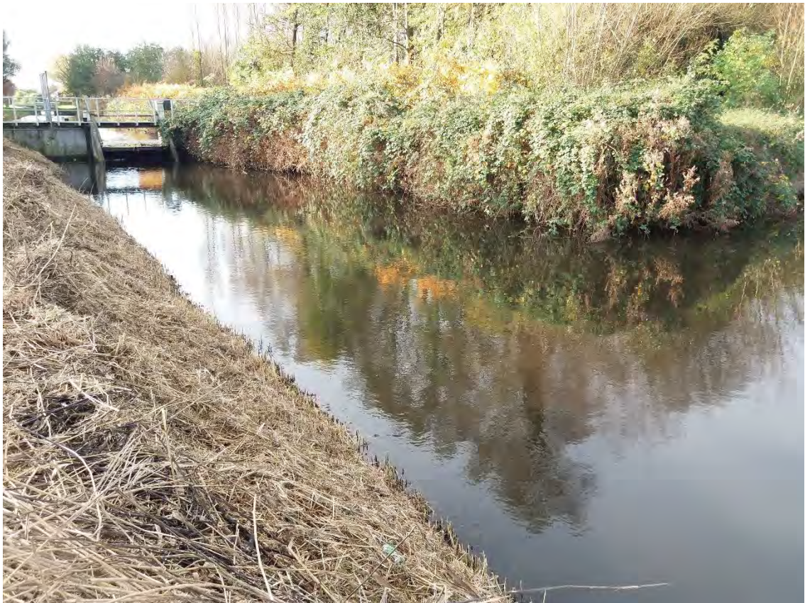
Figuur 8. De aanwezige watergangen kennen steile klei oevers met een 1:1 talud. Er is ofwel gras, ofwel (gemaaid) riet ofwel braamstruweel aanwezig.
