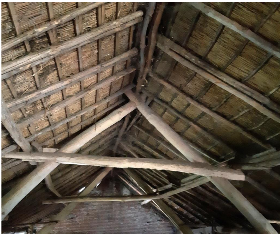
Dak boven stalgedeelte
