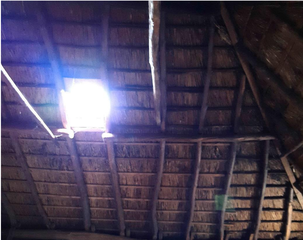
Dak boven woongedeelte
