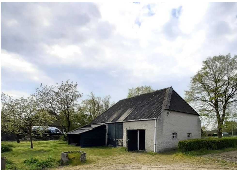
Schuur 1 met asbestdak
