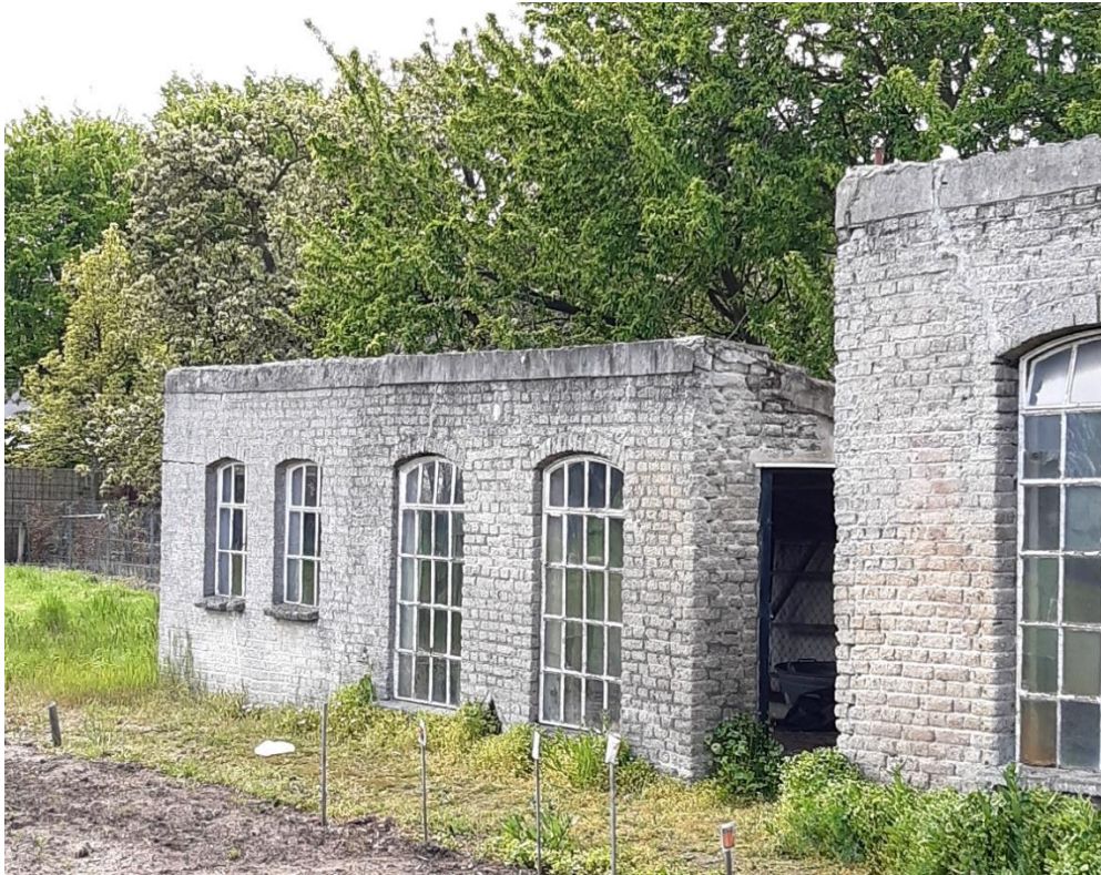
Schuur 3 met dakpannen
