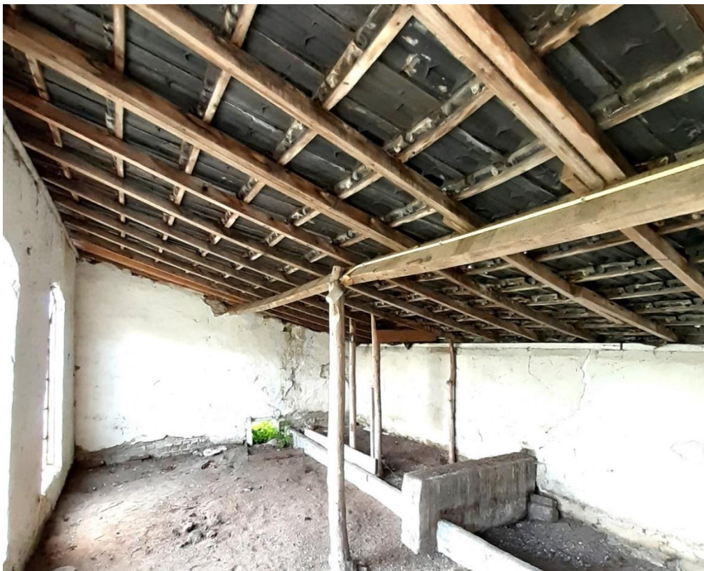
Binnenkant van schuur 3 met dak van dakpannen
