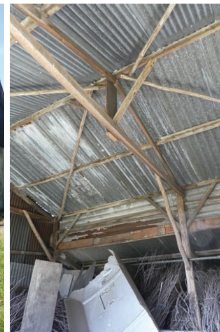
Veldschuur, zicht op interieur noord-westzijde.
