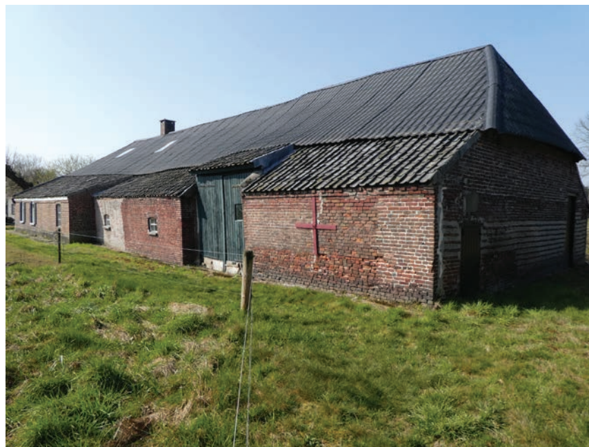
Rechterzijde van zuid-oostgevel.
