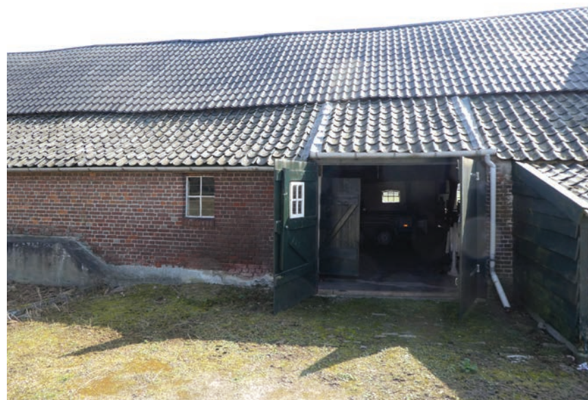
Middendeel van straatgevel.
