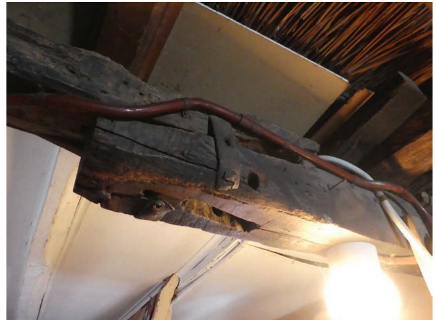
Oorspronkelijk eind van de gebintplaat op str. B.
