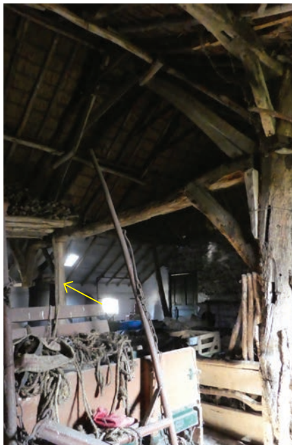
Gebint 7, de pijl geeft een bijgeplaatste standvink aan.
