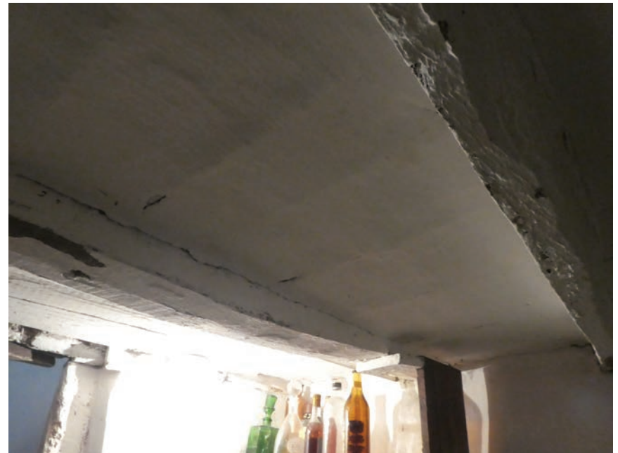
Detail van spelderwerk tussen vloerbalken.
