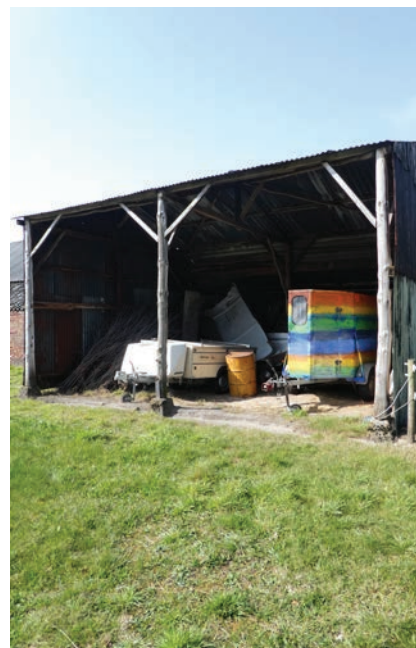
Veldschuur, zicht op interieur noord-westzijde.
