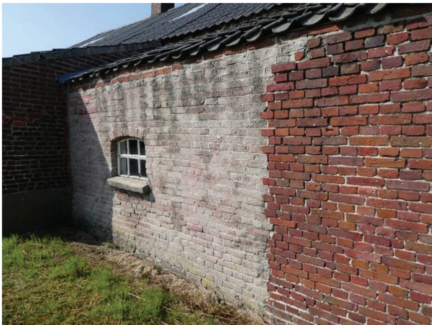
Dichtgezette potstal deur met (oorspronkelijk geroede) cementsteen.
