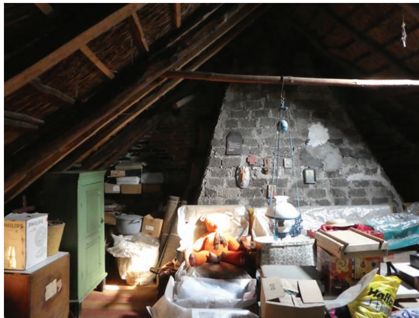
Zolder boven het woonhuis.
