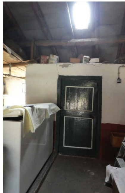
Opgeklampte toegangsdeur van knechtenkamer.
