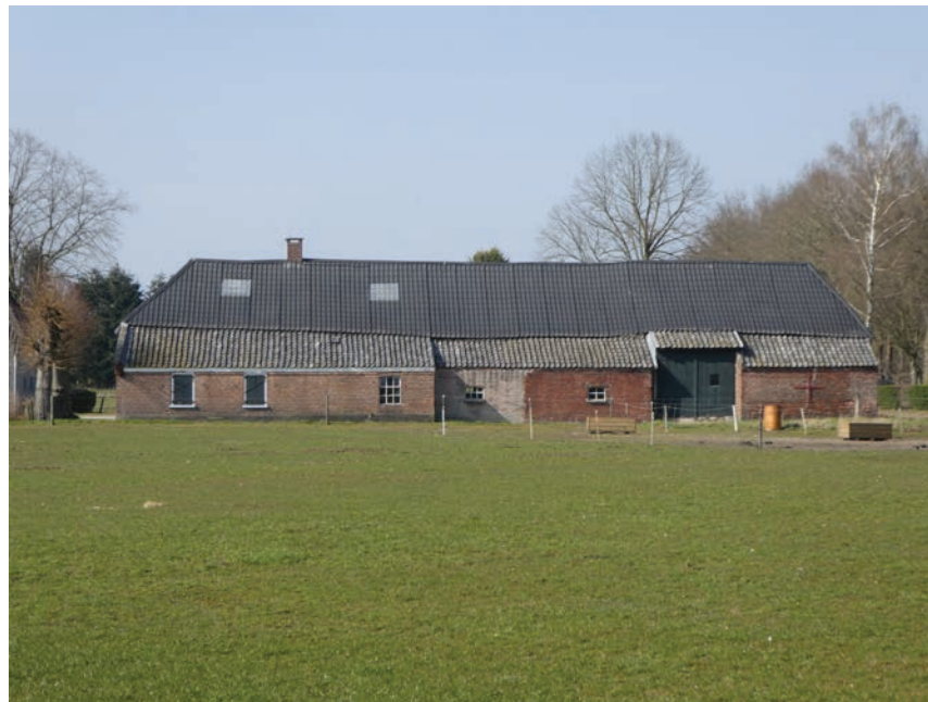
Overzicht van zuid-oostgevel.
