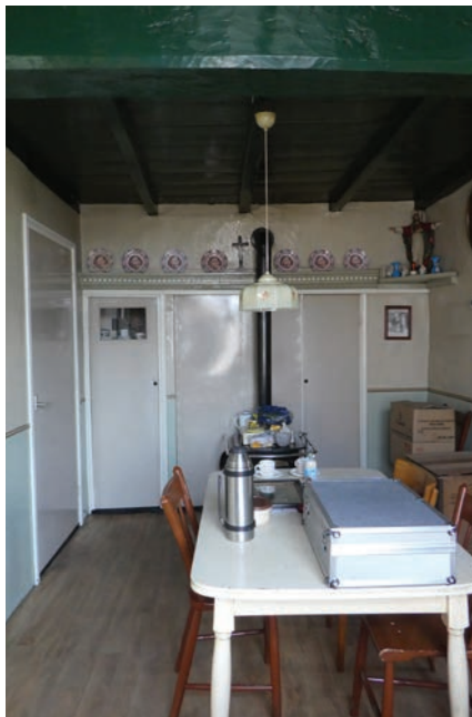
Herd met kastenwand onder haardlijst / schouwbank.
