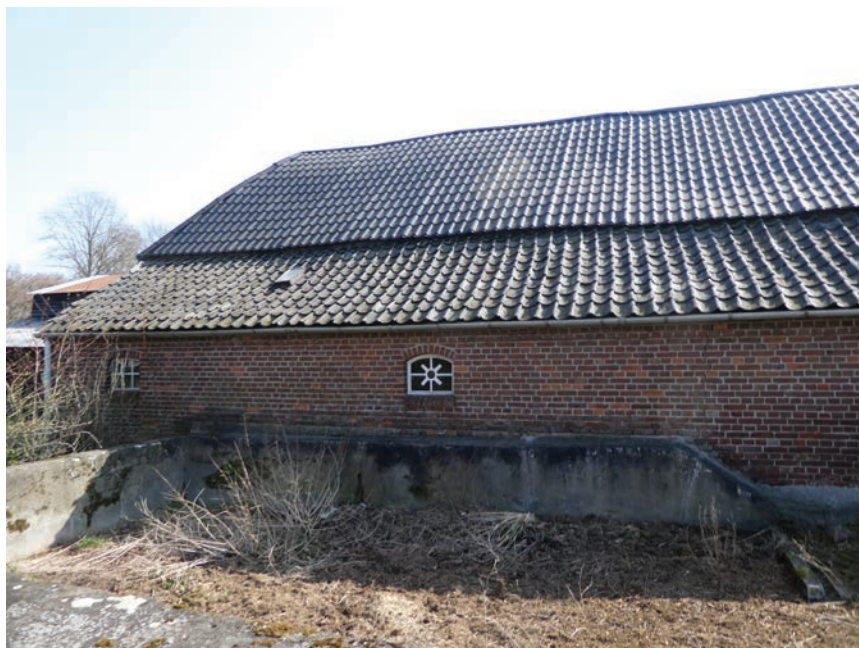
Linkerdeel van straatgevel.
