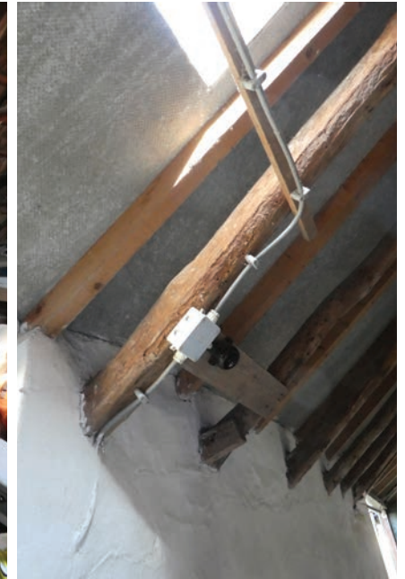
Dubbele dakconstructie (oud en nieuw) in stal.
