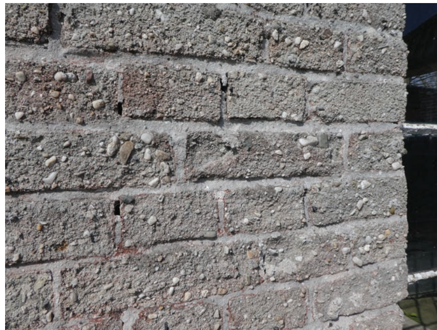
Kippenhok, detail van oorspr. gerood metselwerk van grove cementsteen.
