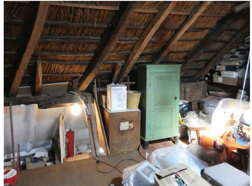
Gebintplaat op str. B. boven het woonhuis.
