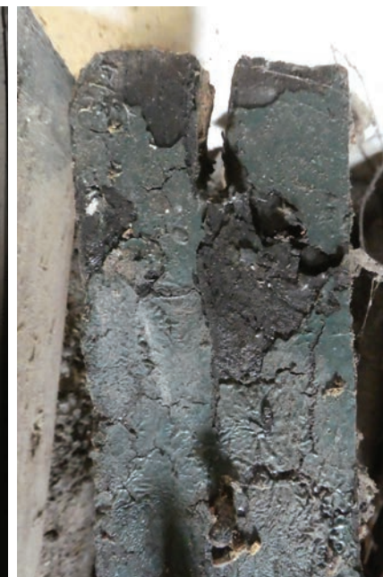
Detail van bewaarde kozijnstijl van potstaldeur.
