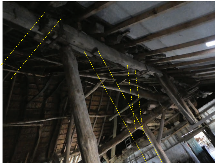
Gebintplaat en stijl op B8. In geel de oude locaties van stijl, schoor en eindplaat.
