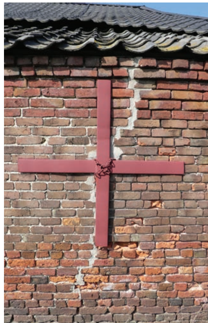
Anker in zuid-oostgevel.
