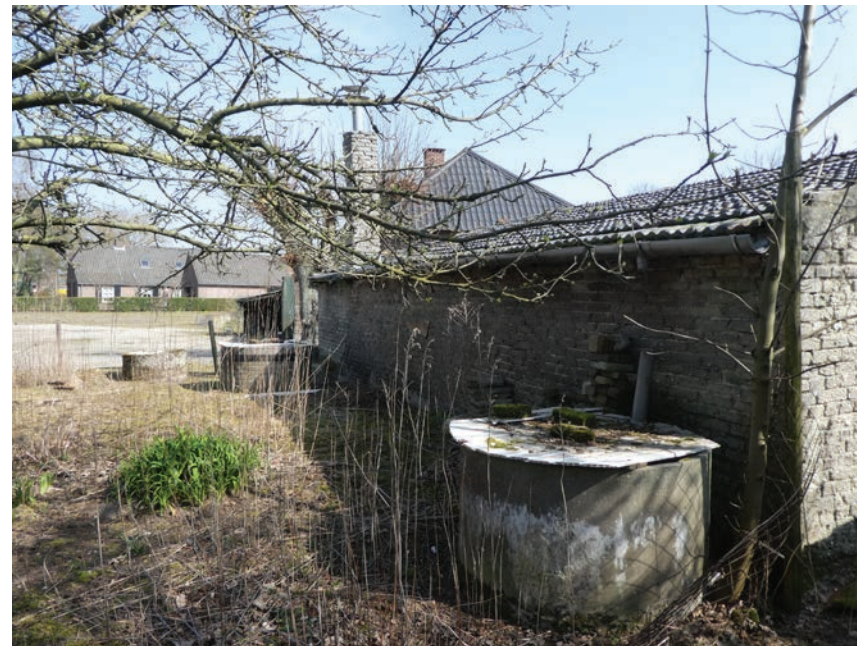
Waterput en regenwaterput tegen kippenhok.
