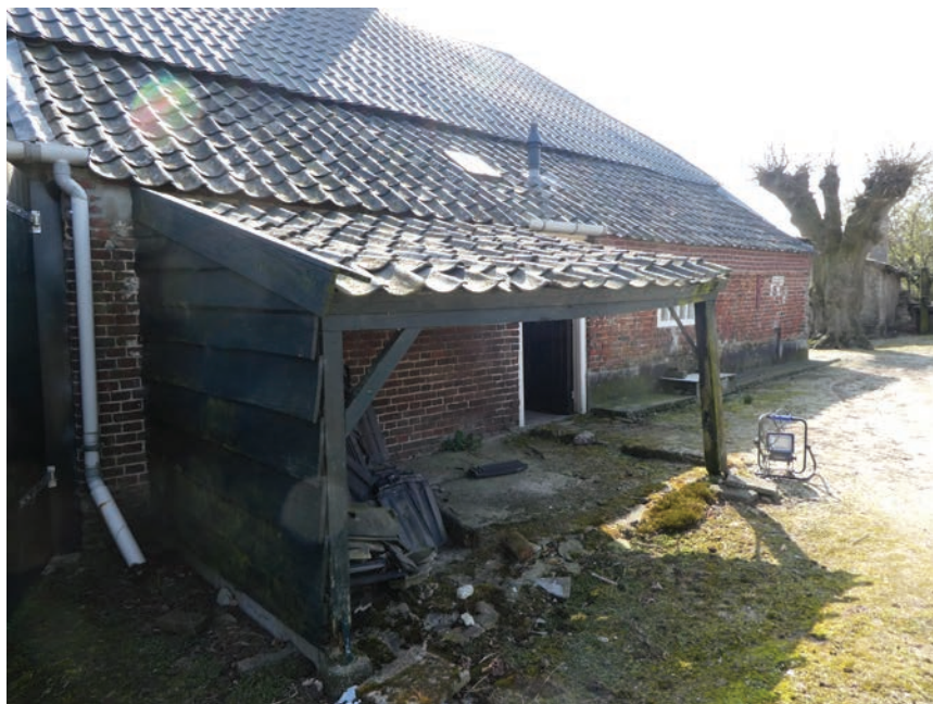
Afhang aan straatgevel.
