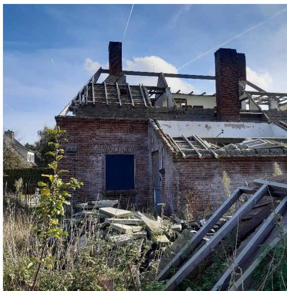
Dakpannen en dakbeschot zijn verwijderd
