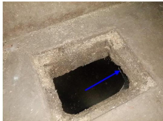
Foto 12 | Betonvloeren met betonelementen op mestputten
