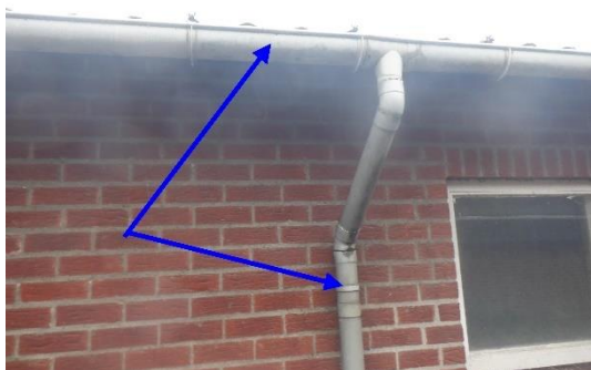
Foto 21 | Pvc hemelwaterafvoeren
