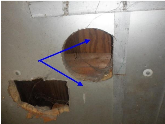
Foto 7 | Dupanel platen en houten dak
