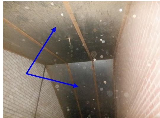
Foto 10 | Dupanel platen tegen de dakschuinte
