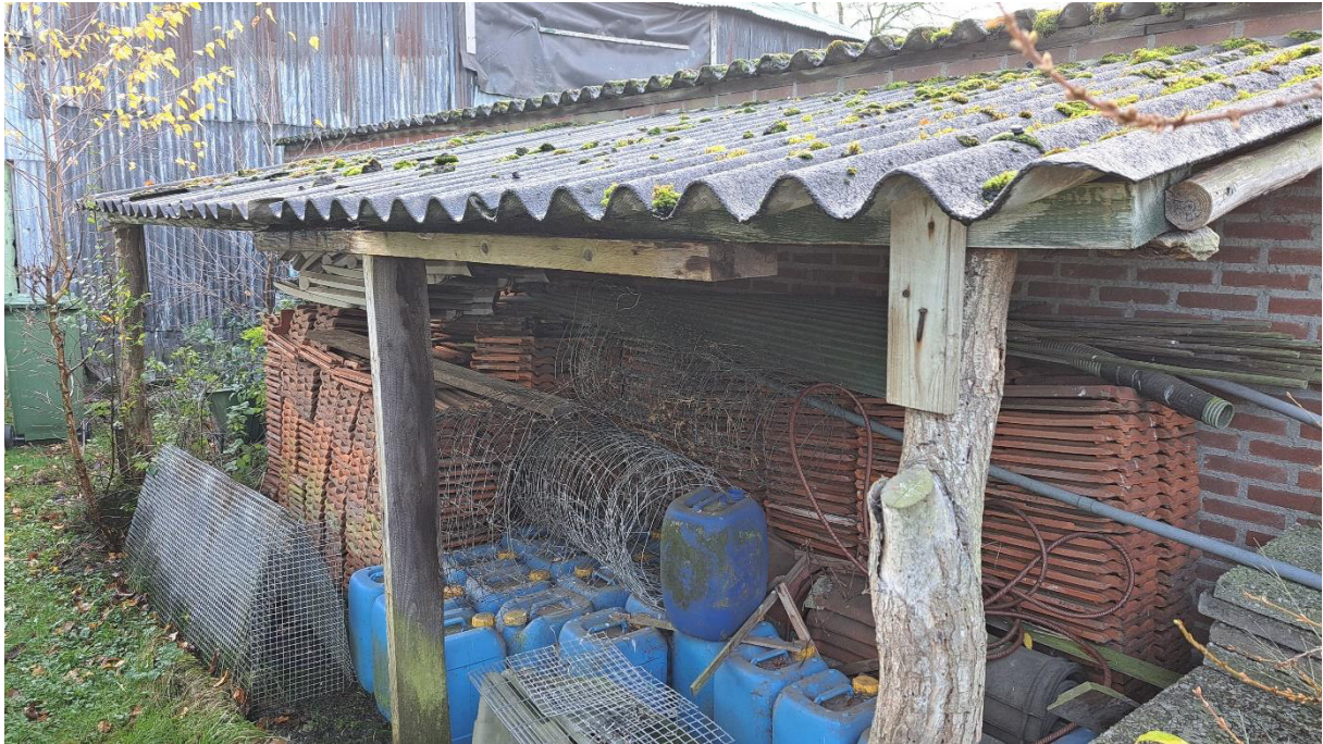
overkapping bij gebouw 3
