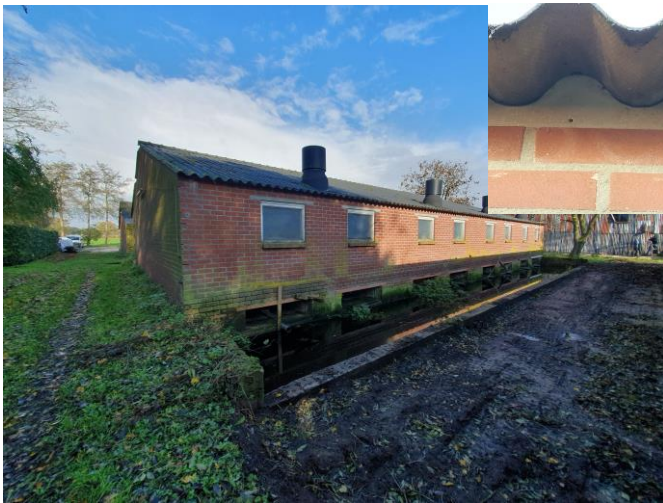
Indruk van een konijnenstal, afgedichte ruimtes tussen golfplaten en zijgevel en de binnenzijde van de stal.
