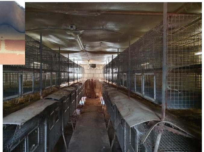
Indruk van een konijnenstal, afgedichte ruimtes tussen golfplaten en zijgevel en de binnenzijde van de stal.
