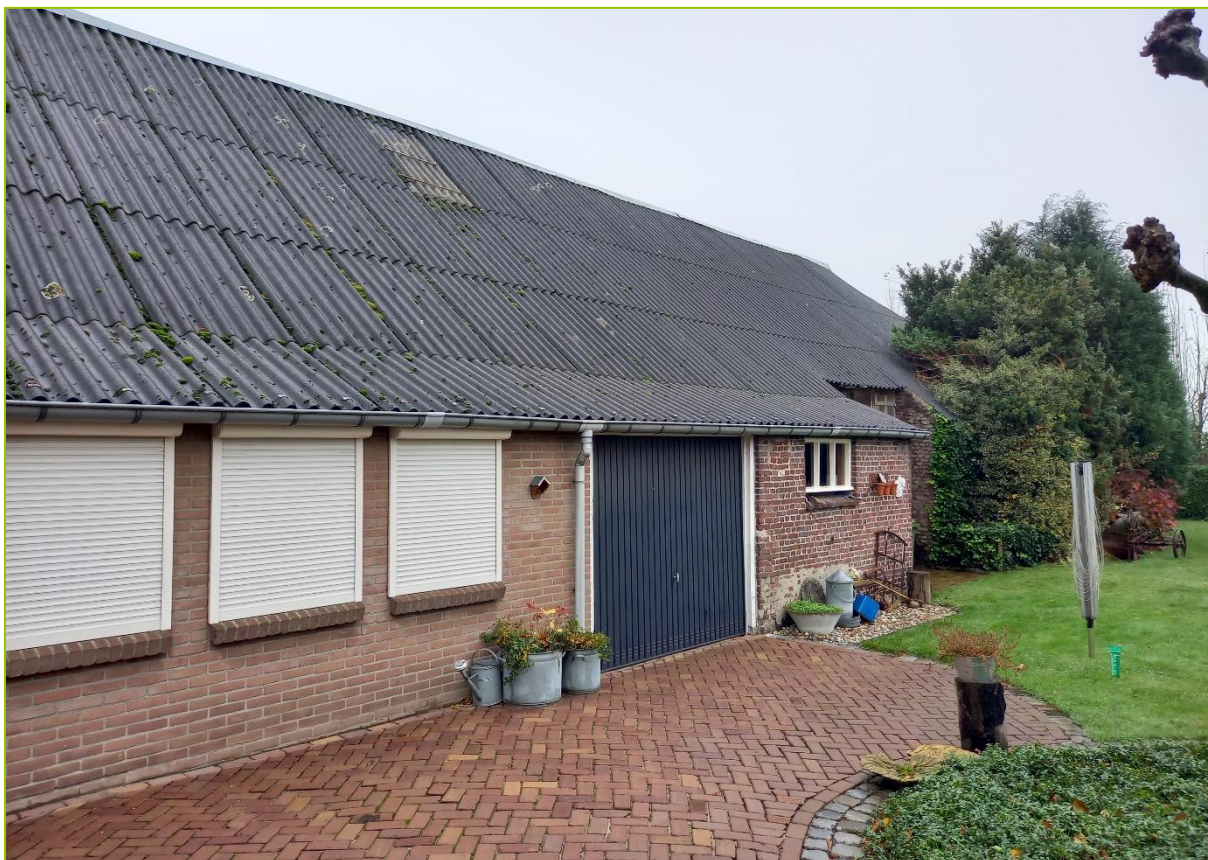
De schuur is opgetrokken uit gemetselde gevels en is voorzien van een enkele laag golfplaten als dak.
