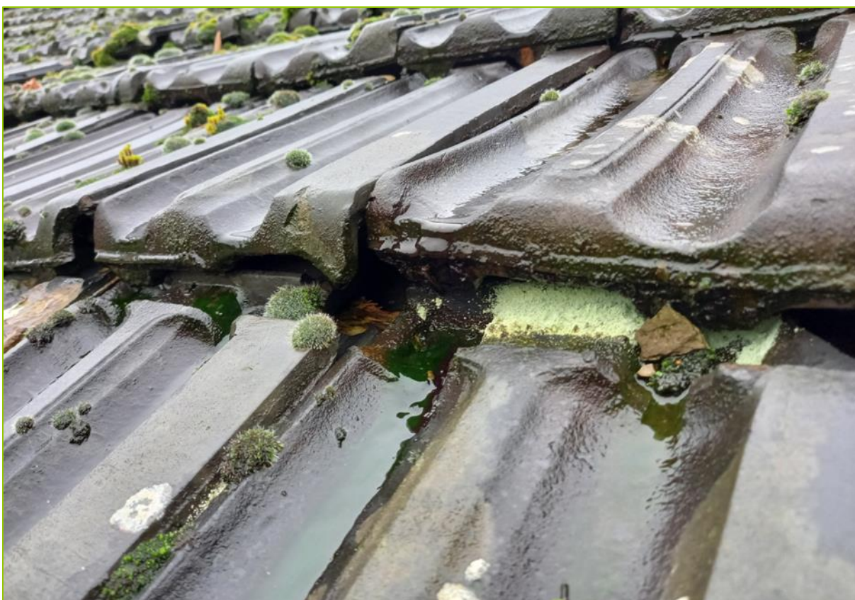
Het lage pannendak aan de noordzijde van de schuur heeft enkele openingen. Hieronder zijn echter geen nesten van huismus aangetroffen.
