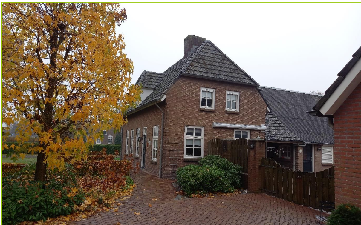
De planlocatie betreft een boerenschuur aan een woonhuis aan het Achter Oventje 9 te Zeeland
