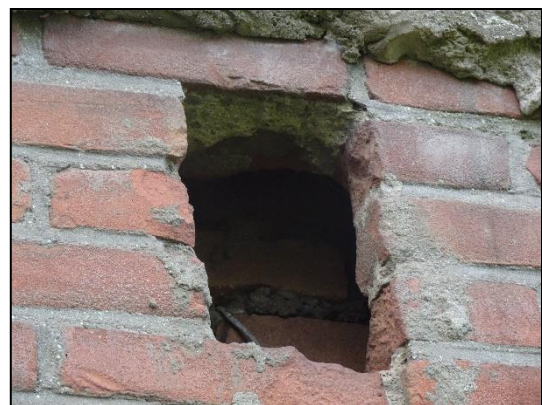
Figuur 12. Openingen in de muur die gebouwbewoonende vleermuizen toegang bieden tot de spouwmuur.
