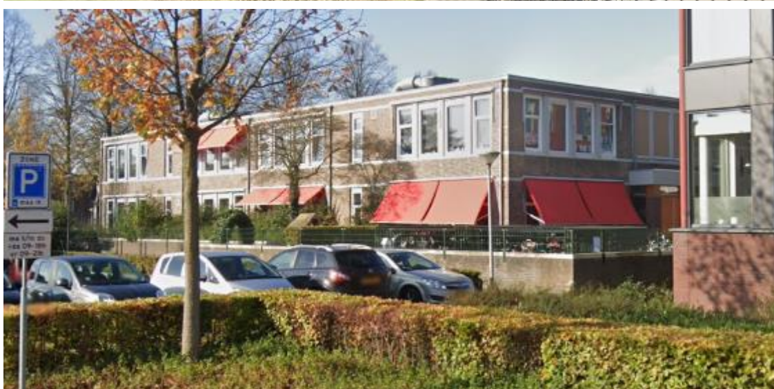
Figuur 2.1 Impressie huidige situatie (kindcentrum Aventurijn; Bron: Google Streetview)
