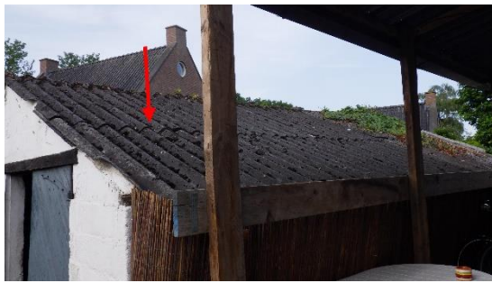
foto 54 | foto voor bron dakbedekking
