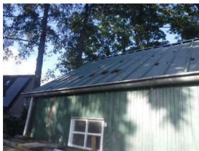
Foto 2 metalen dak- en gevelplaten - veldschuur
