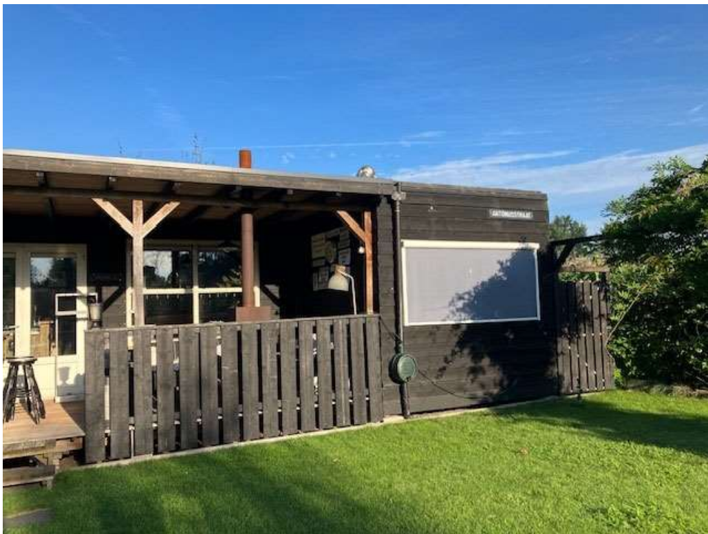
• Afbeelding 9: Gebouw 2, wordt deels gesloopt rechter gedeelte
