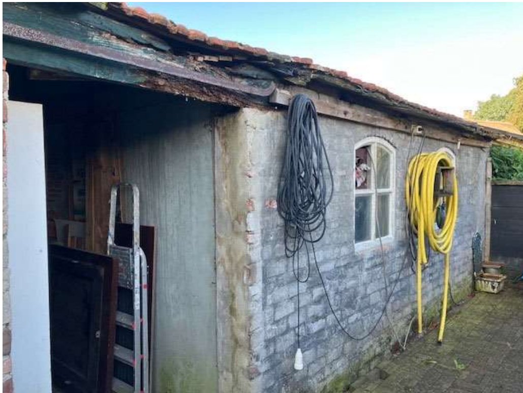
• Afbeelding 8: Gevel gebouw 1, laag, geen dakgoot, steens muur zonder openingen
