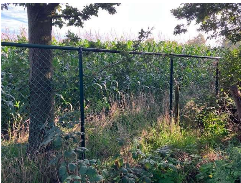
• Afbeelding 24: hekwerk als begrenzing met maisperceel aan achterzijde
