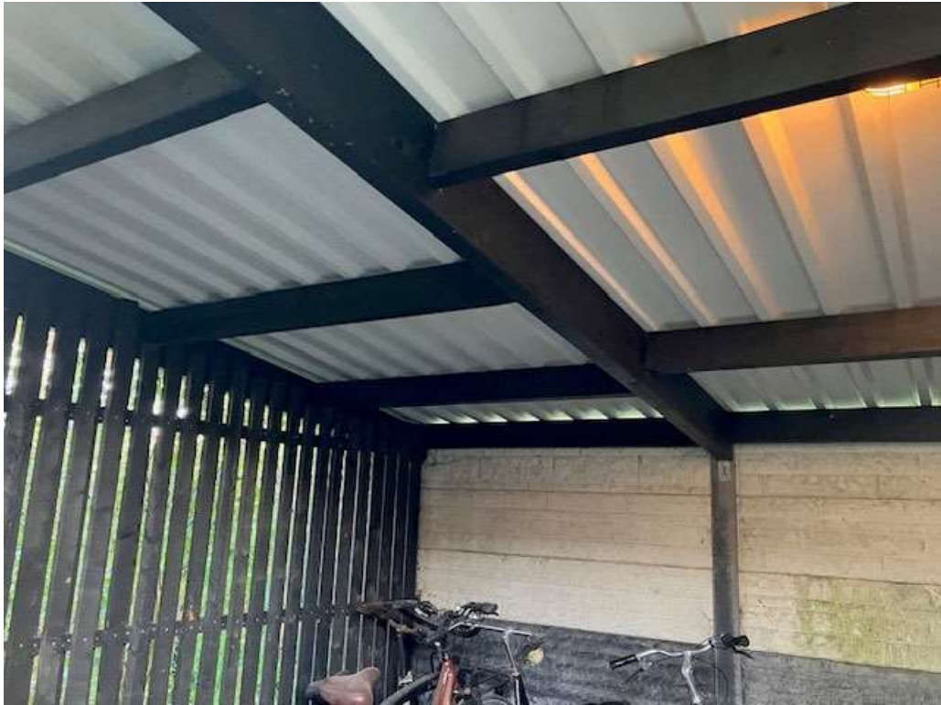
• Afbeelding 12: Binnenzijde gebouw 3, damwand dak, muur enkel steens
