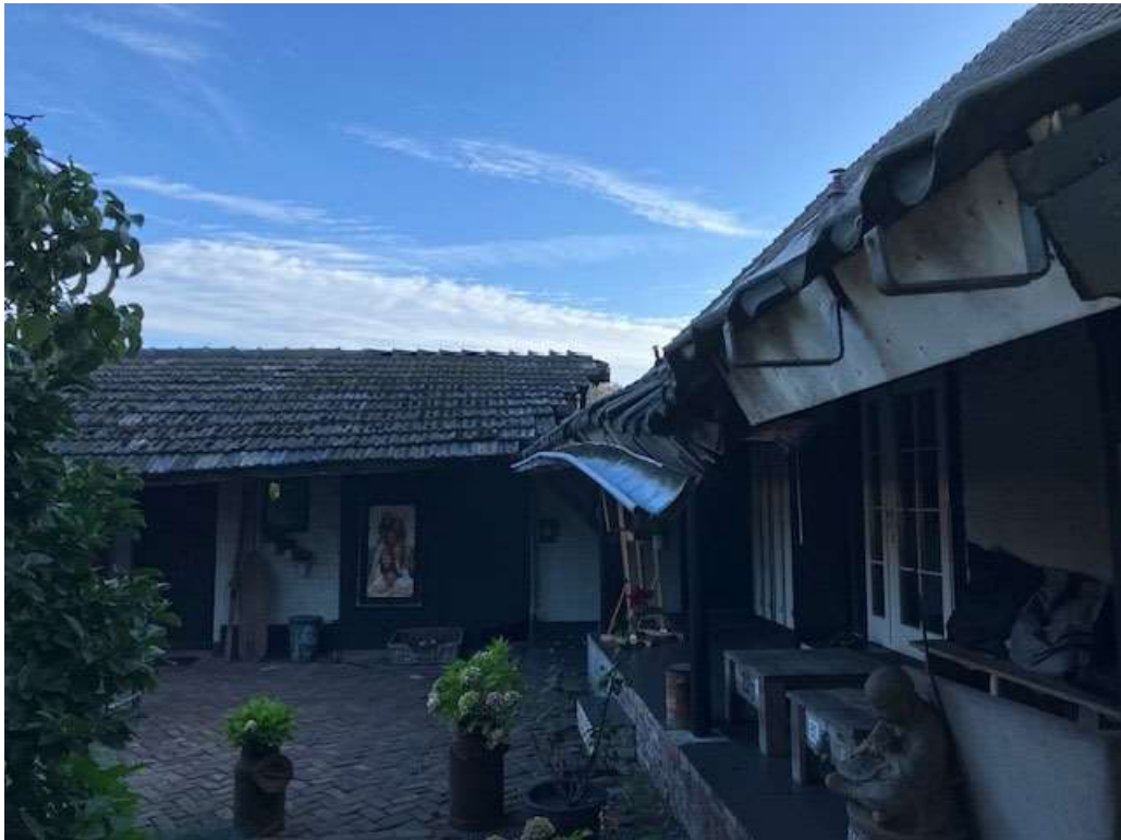
• Afbeelding 3: Gebouw 1 links wordt gesloopt
