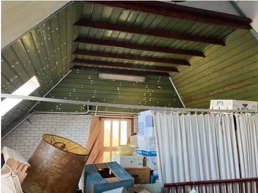
• Afbeelding 18: Zolder en dak
