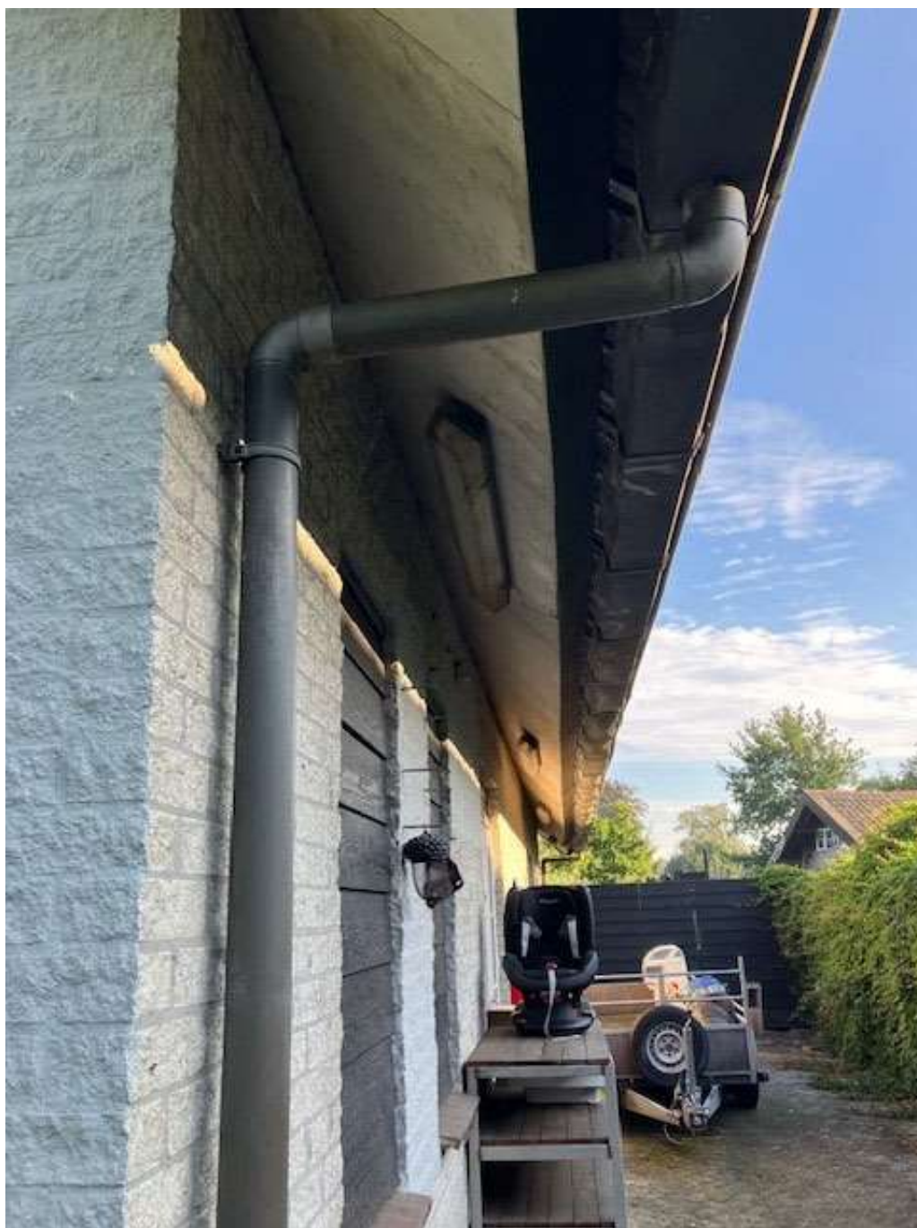
• Afbeelding 21: Aansluiting dak
