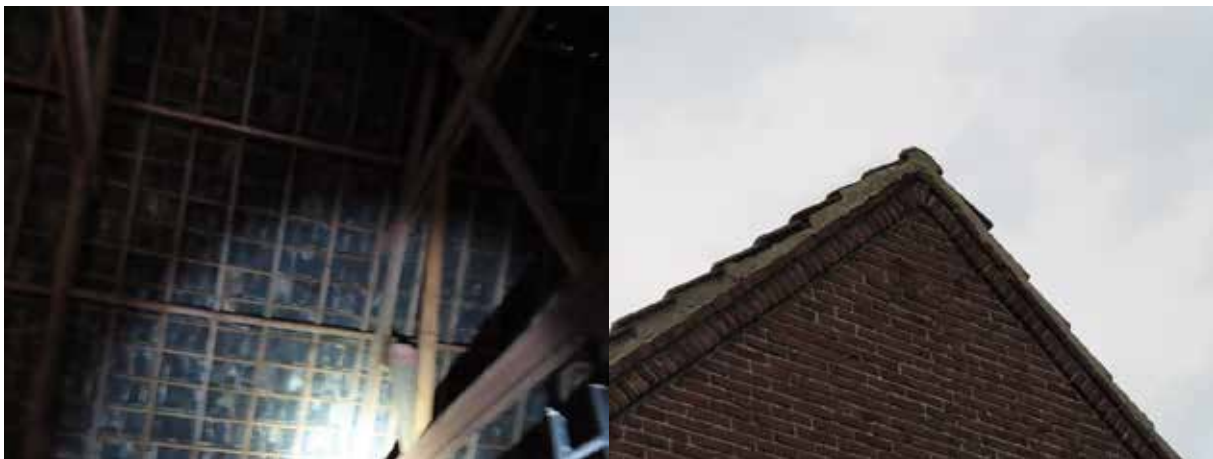
Afbeeldingen 13 en 14: geen openingen, potentiële verblijfplaatsen of sporen van vleermuizen aangetroffen. Bron: BNL advies.
