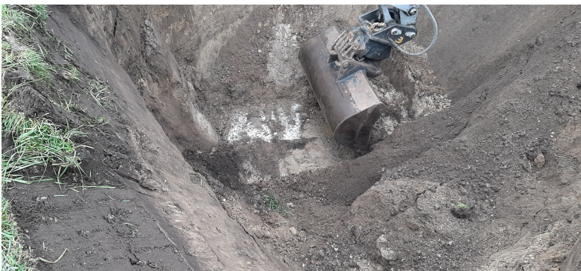
Figuur 3: Eén van de oude betonnen funderingen.
