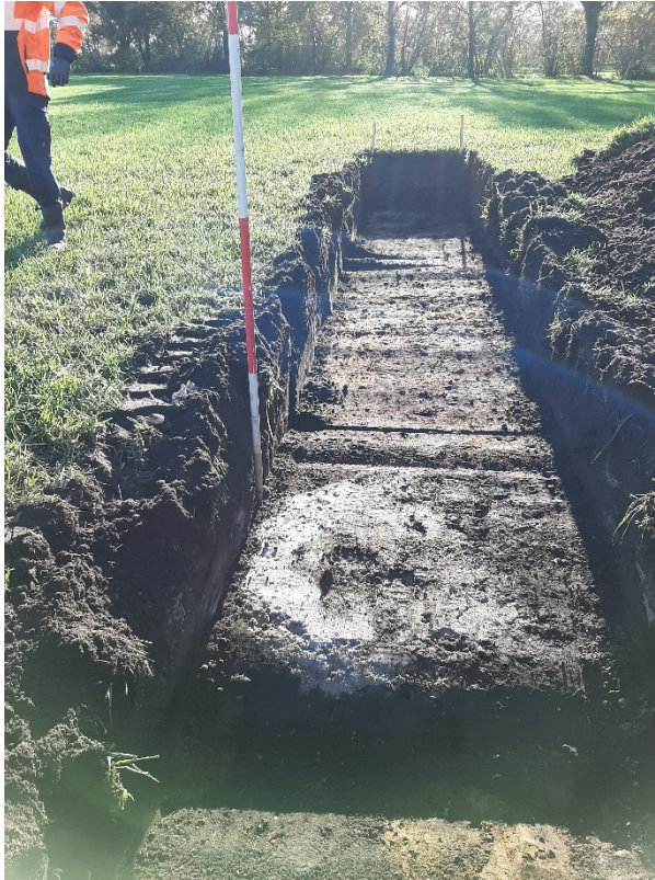
0,4 m-mv met beton (voor jalon)
