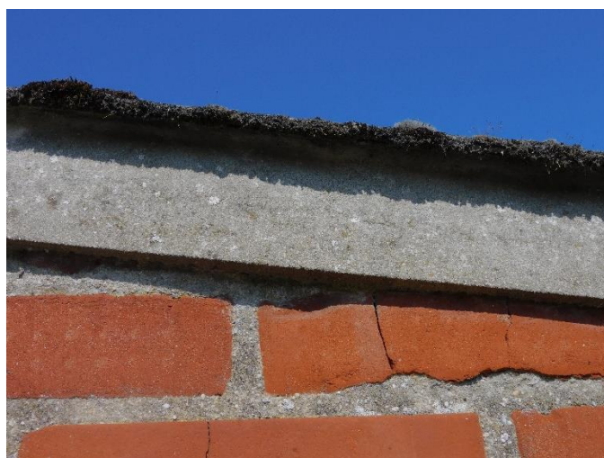
Aangemeerd dak op de zijgevels
