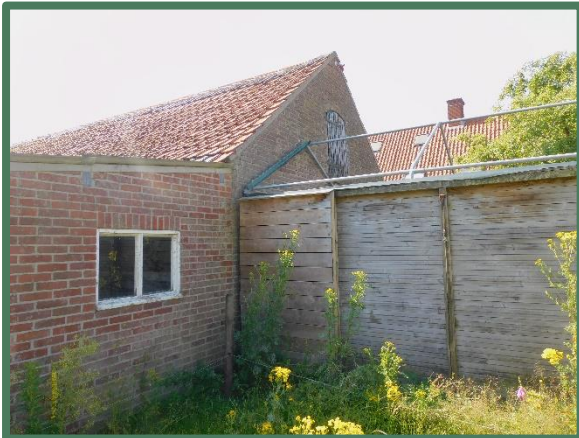
Aanbouw aan schuur
