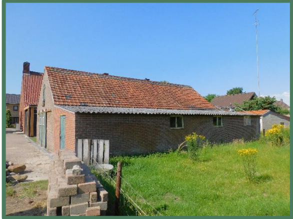
Te slopen aanbouw
