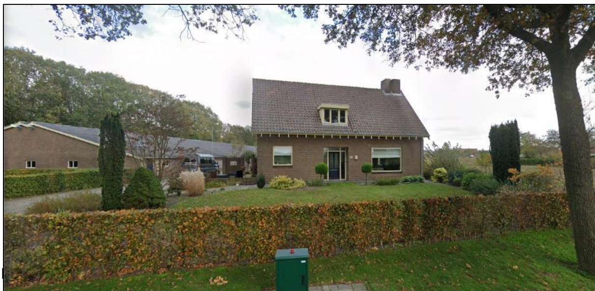
Figuur 4: Foto aanzicht locatie Strikseweg 3
