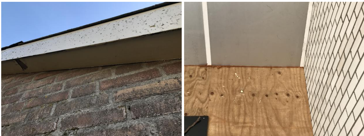
Afbeelding 9 en 10: Overstek goed aansluitend aan buitenmuur en kieren goed afgesloten met purschuim. Bron: R.J.L. Bijvelds. Datum: 12-04-2021
