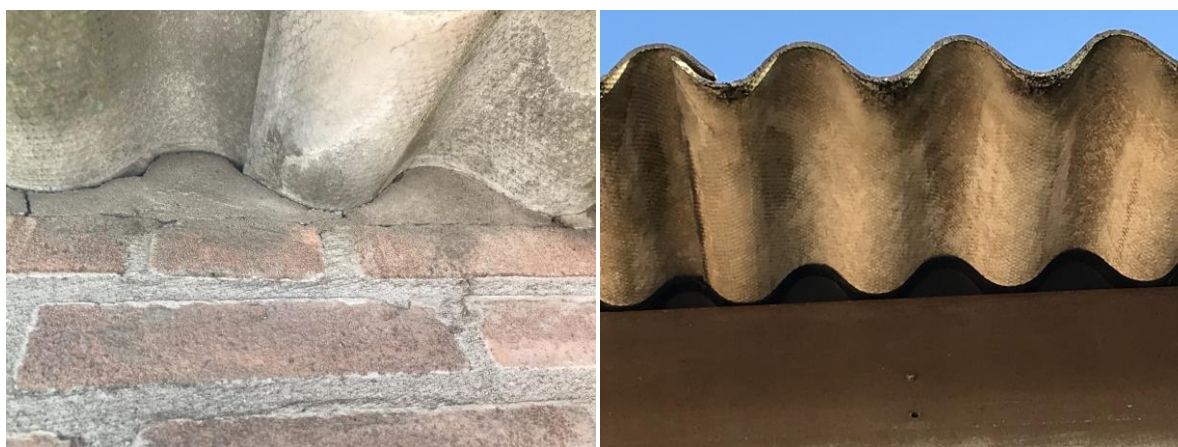
Afbeelding 6 en 7: Daken met vogelschroot en cement om de toegang te versperren. De aanwezigheid van huismussen is uitgesloten door het ontbreken van mogelijk geschikte verblijfplaatsen. Bron: R.J.L. Bijvelds Datum: 12-04-2021
